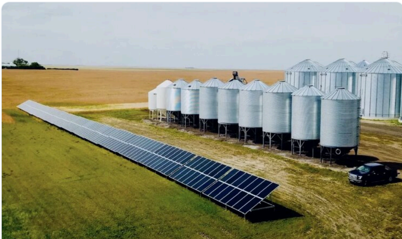
Ferme céréalière — champ solaire au sol
