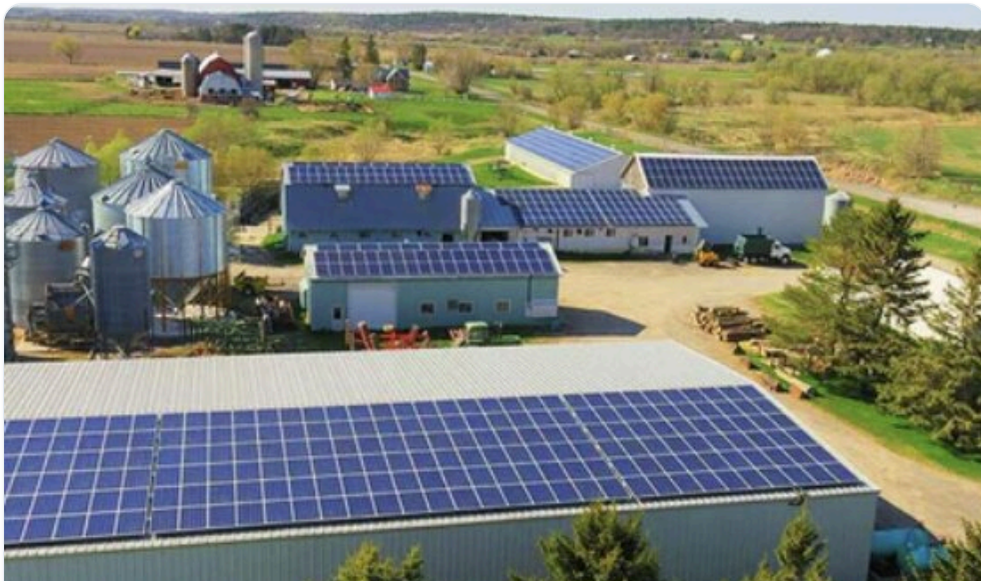
Atelier et hangars de ferme céréalière
