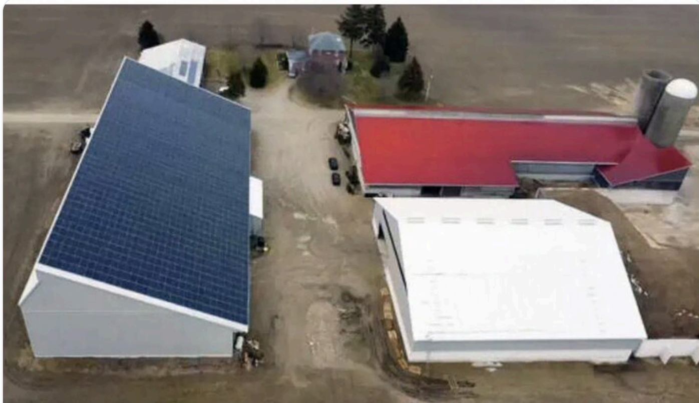
Remise à machinerie / grange
