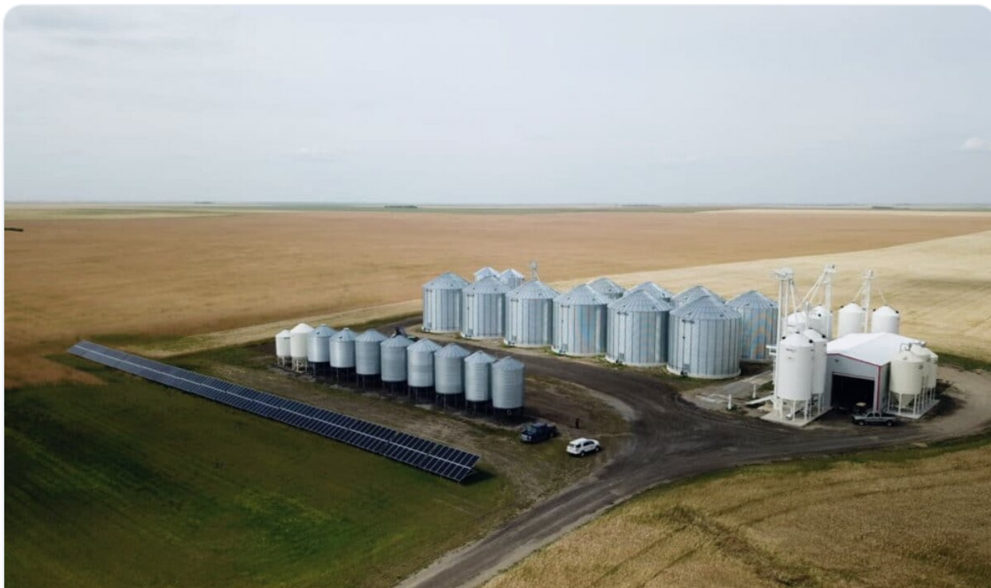
Ferme céréalière — champ solaire au sol
